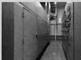
非常用発電設備
